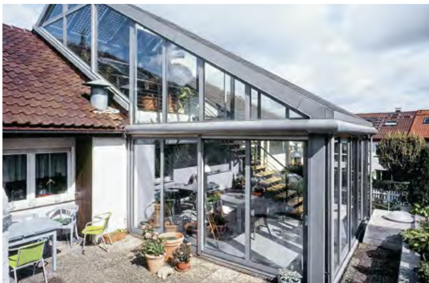
Renovering En harmonisk tilbygning
